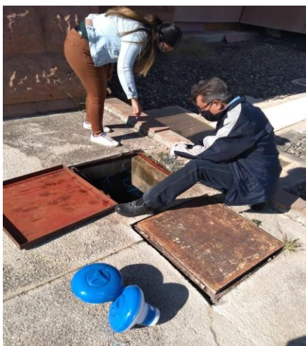
Imagen 80. Colocación de los flotadores dentro de la cisterna A.
